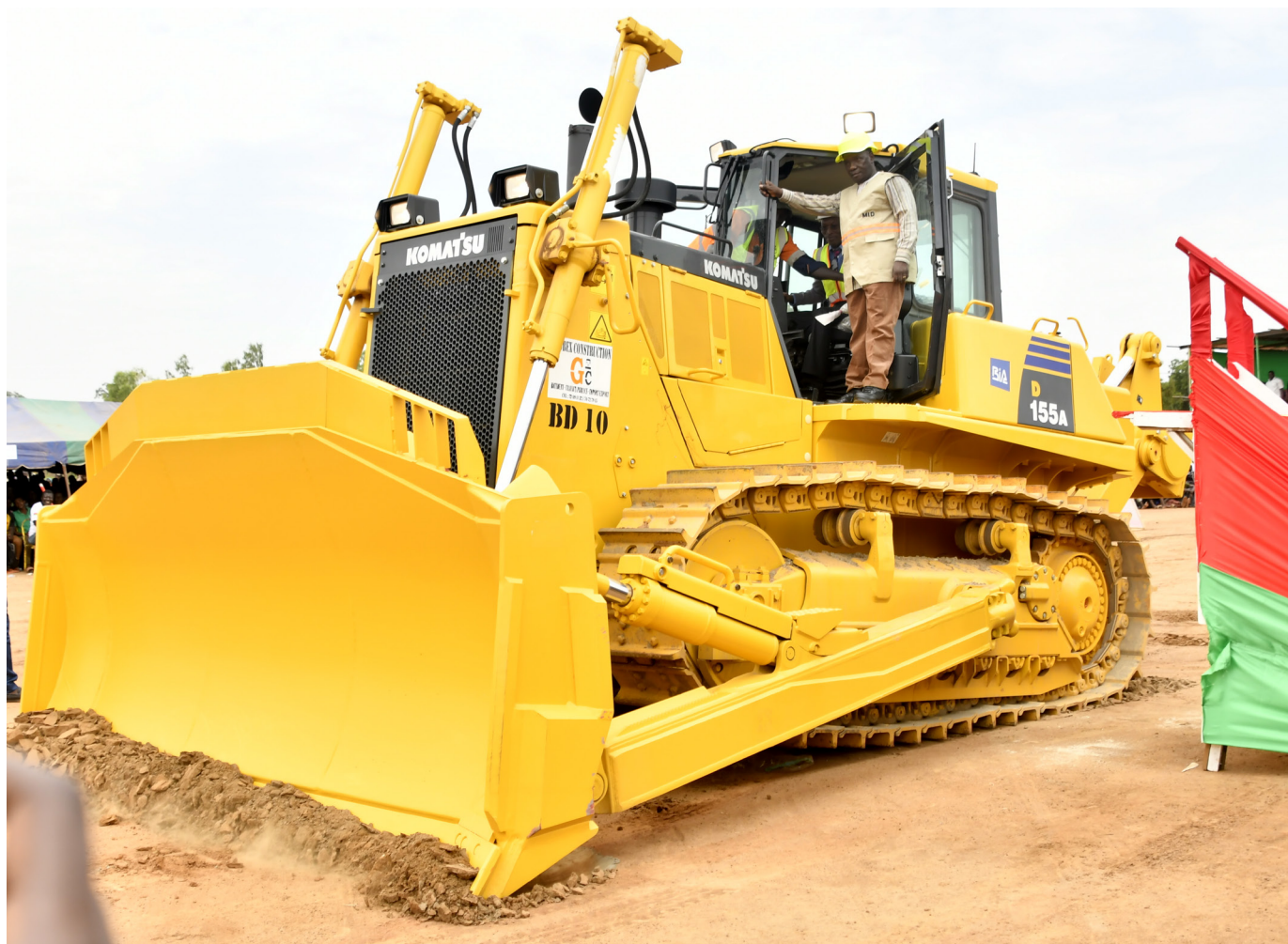
Lancement des travaux d'extension de la route nationale 4 (RN4), l'élargissement de la chaussée en 2×2 voies sur un linéaire de 21 km
